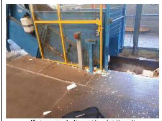
Photographie 3 : Fosses (dans le bâtiment)
